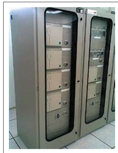
Рис. 2. Применяемый сегодня способ монтажа МУРЗ в шкафы
