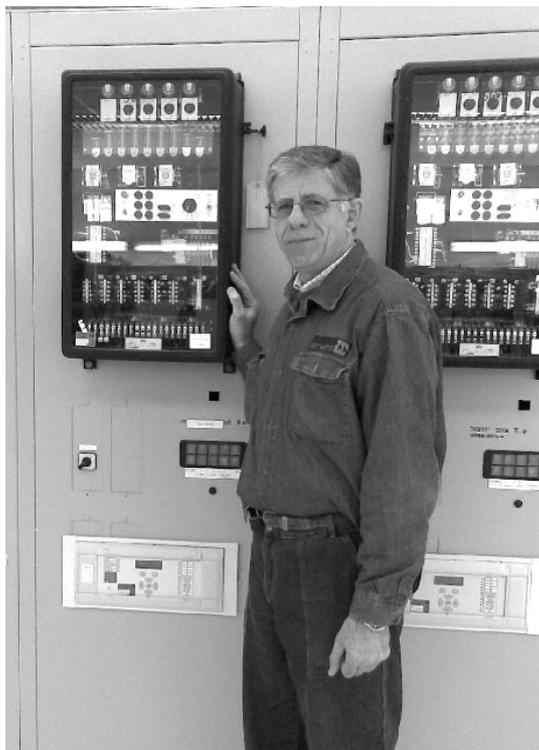
Недавно я был на одной из наших подстанций и специально для ответа рецензенту сделал мобильником фото панели релейной защиты с установленными параллельно электромеханическими реле дистанционной защиты LZ31 (вверху), упоминаемым в статье, которому уже 30 лет отроду и новейшими микропроцессорными устройствами дистанционной защиты MiCOM P437, фирмы AREVA (внизу).
