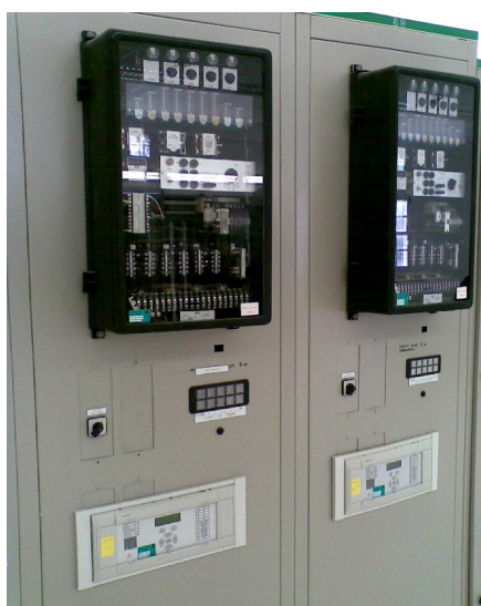
Рис. 1. Электромеханические дистанционные защиты типа LZ31, выпущенные более 30 лет тому назад (сверху) настолько надежны, что их включают у нас сегодня на параллельную работу с микропроцессорными реле (внизу) для подстраховки последних на особо ответственных линиях электропередач.
